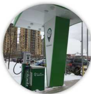
Зарядная станция (Mode 3 AC)
